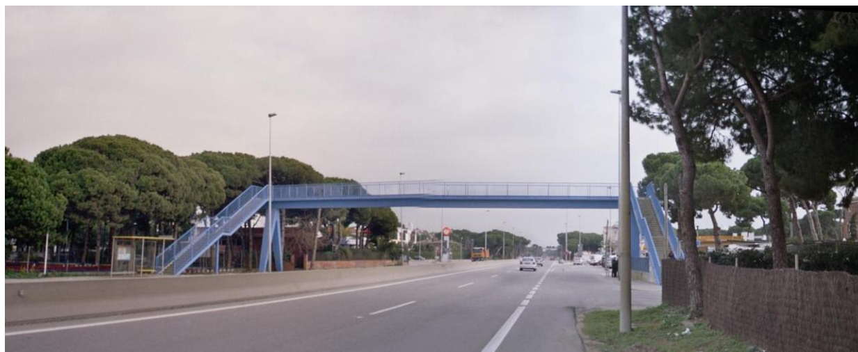
Fig 2. Vista general de l'estat actual de la passarel·la
